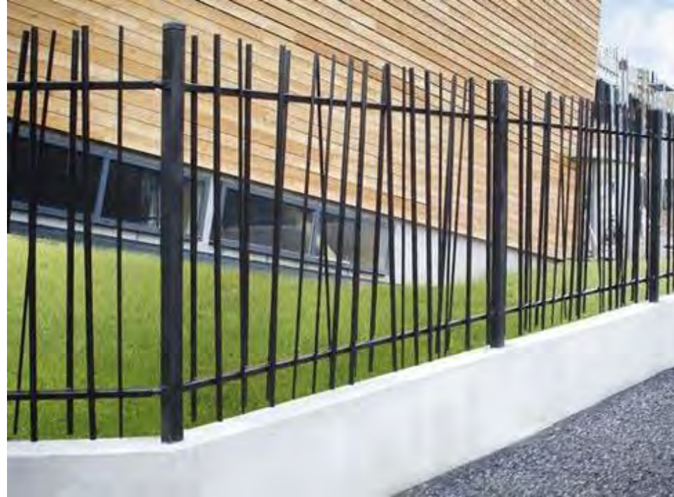
Mustaksi maalattu epäsymmetrinen teräskaide , tukimuuri sileää betonia Vaalean ja mustan, sileän ja epäsymmetrisen moderni kontrasti.
