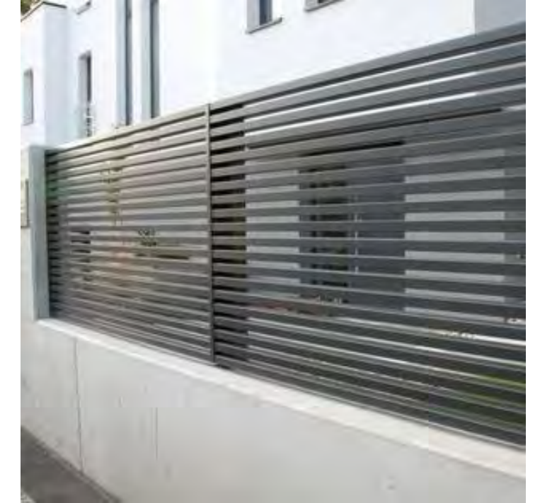
Teräskaide, vaaka , tukimuuri sileää betonia Riittävä välistys tärkeä, jotta risteyksen toiselle puolelle näkyy.
